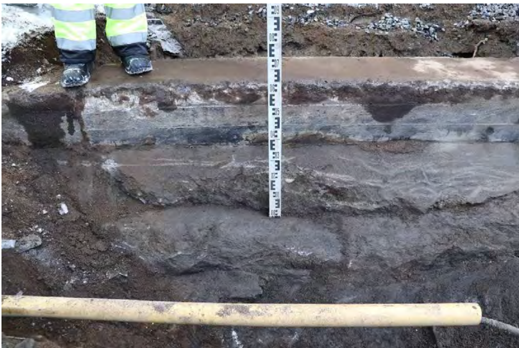
Kuva 7. Rakenne B1:n itäseinämä. Latta lepää betonisen osan alla olevan ensimmäisen kivikerran päällä. Kuvattu koillisesta. (Kuva: Tampere Frenckell 2019:11)
